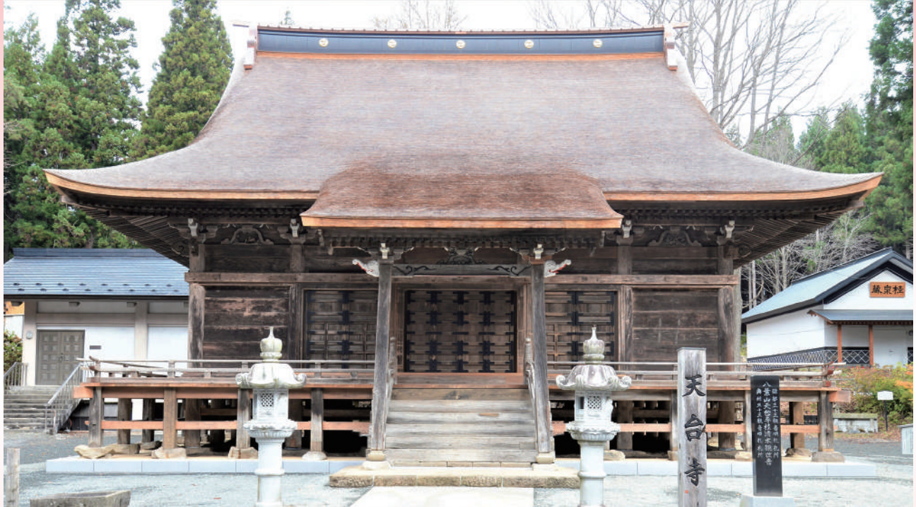
天台寺本堂は建立当初の姿に復し、屋根も杉板を重ねた「とち茸」に復原いたしました。
