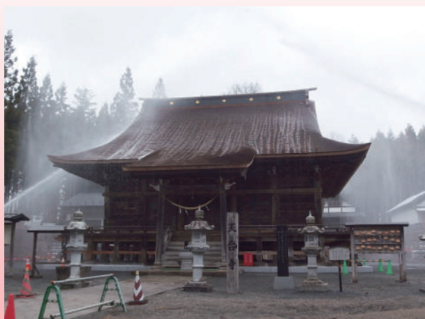
本堂への放水銃作動状況
