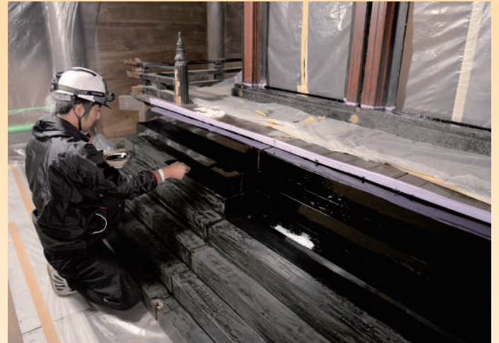
以前仏像を納めていた厨子 ずし の階段の塗り直し
