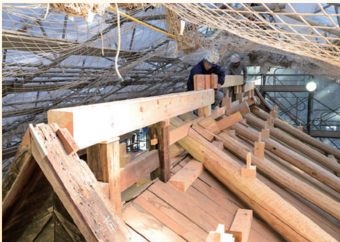
仁王門の屋根下地の組み立て
