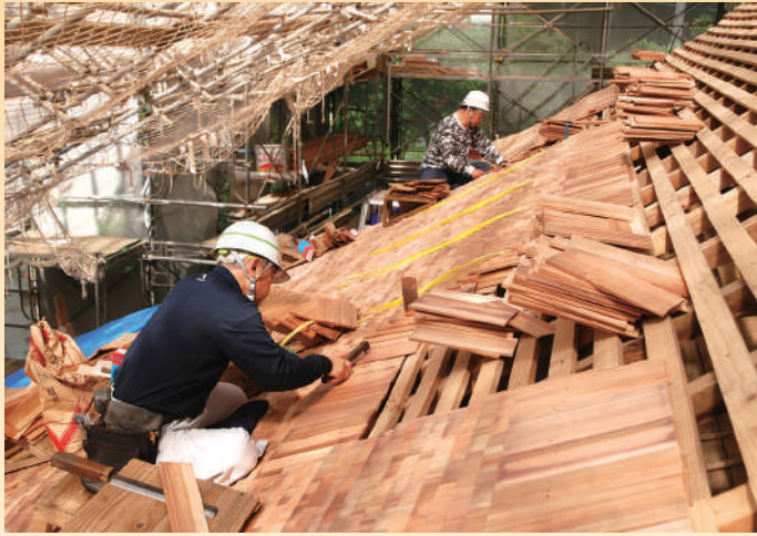
本堂屋根に板を葺いていく様子
