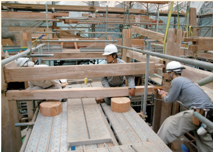
修理のため解体した部材を、元のよう に 組み直す
