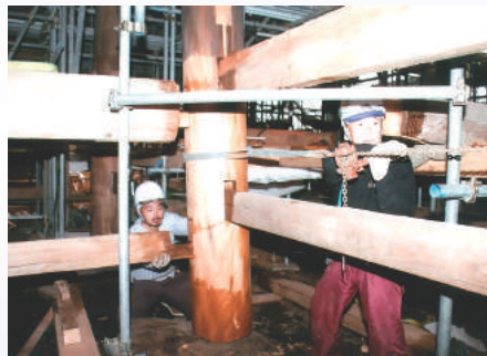
建て直した柱に部材を元通り建て込む
