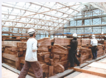
建て直した柱に部材を元通り建て込む
