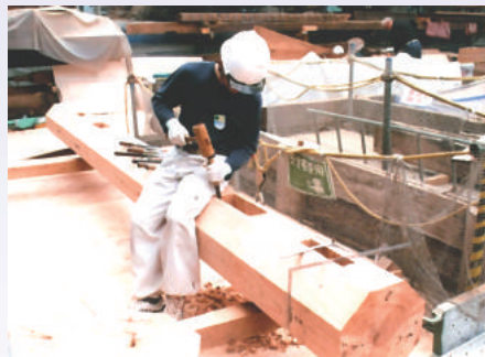
元の部材の形に合わせて新材を加工
