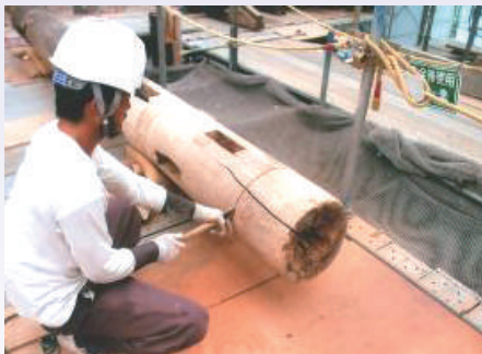
傷みの激しい部分を切り落とす
