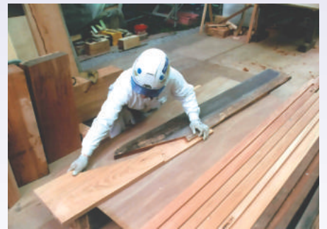
元の部材の形に合わせて新材を加工
