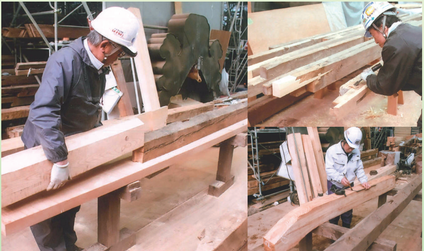
古材補修及び取替新材加工中
