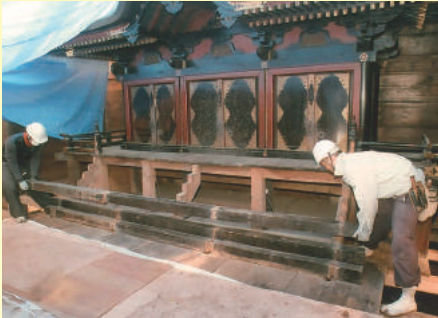
造り付けの厨子は階段部分を外し、ブルーシートで保護
