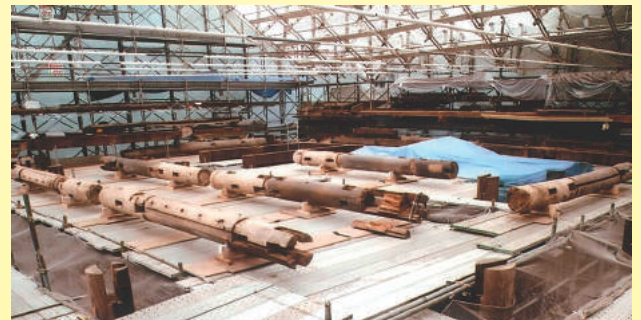
柱も特に傷んでいた6本を補修のため取り外した
