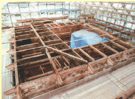
再び地上に下ろし、解体作業を再開
