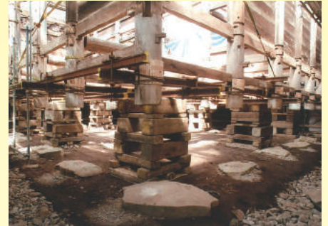
本堂をジャッキで持ち上げ、井桁状に組んだ材木で地上から1.2m程の高さに固定
