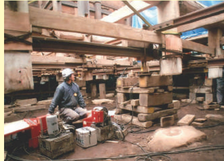
本堂をジャッキで持ち上げ、井桁状に組んだ材木で地上から1.2m程の高さに固定
