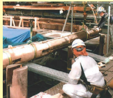
柱も特に傷んでいた6本を補修のため取り外した
