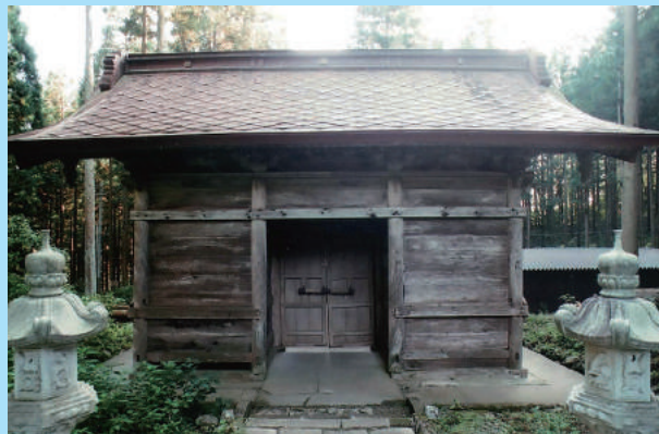
門扉閉鎖状態
