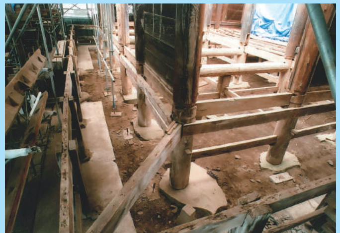
縁廻り解体後
