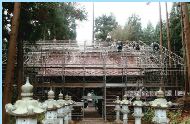
仮囲い設置中
