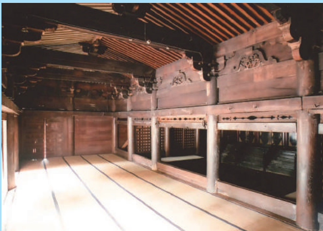
工事に際して片付けられた本堂内部
