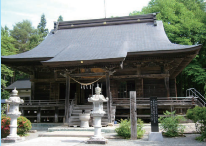
工事着工前の本堂
