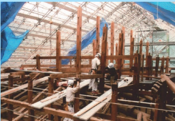
屋根骨組みには古い材料が多く残っていた
