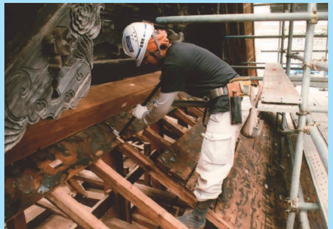
解体は全て手作業
