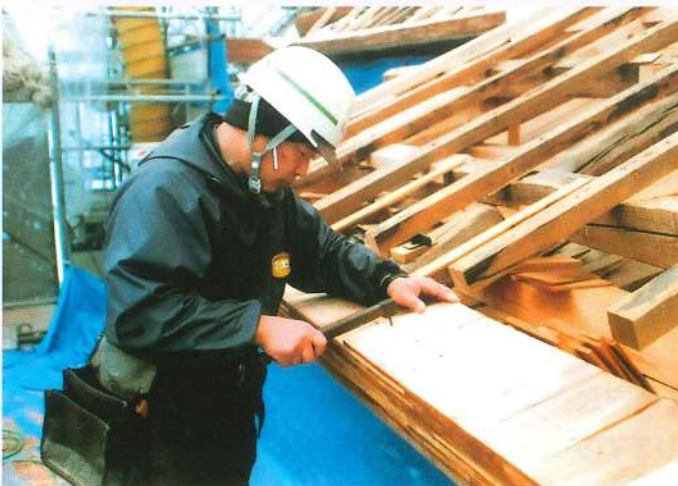
軒先での屋根葺き作業。厚さ1cm程の杉板を竹釘で打ち付け、雨漏りがしないよう何重にも重ねていく
