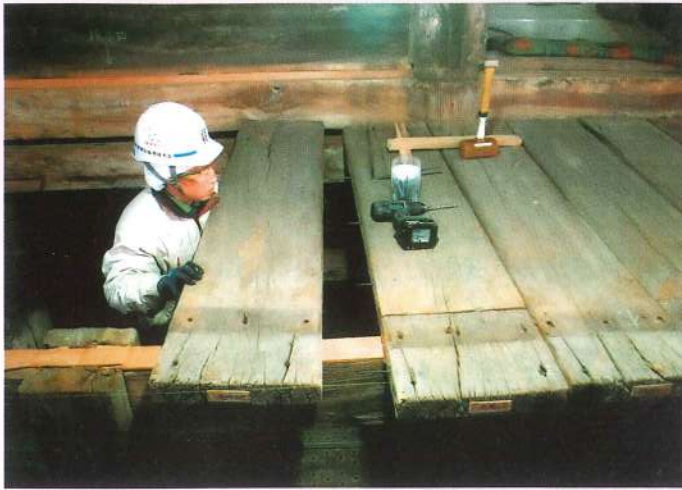
本堂縁周りの作業状況。桂材も用いられていた。 風雨で傷みが激しかった箇所は新材に取り替えている
