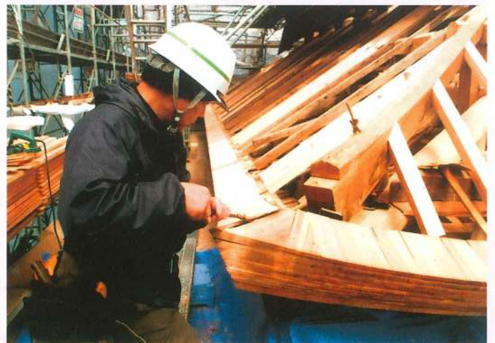
軒先での屋根葺き作業。厚さ1cm程の杉板を竹釘で打ち付け、雨漏りがしないよう何重にも重ねていく
